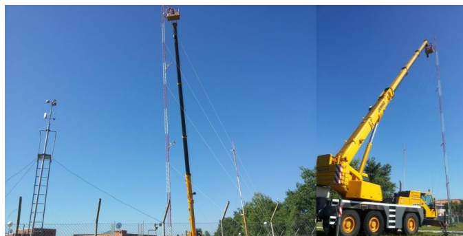
Figura 1: Colocação do ultra-sónico a 30m
